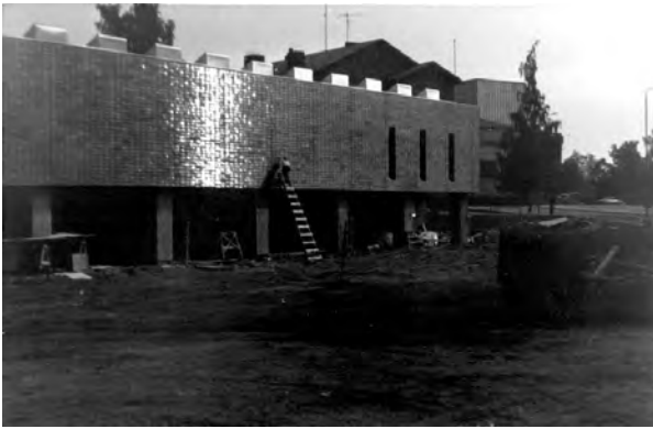
Kuva 50. Kirjaston julkisivuvuon laatoituksen saumaustyö 1971.
