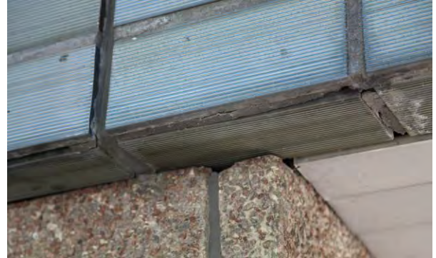
Kuva 130. Kahden julkisivuelementin liitos.
