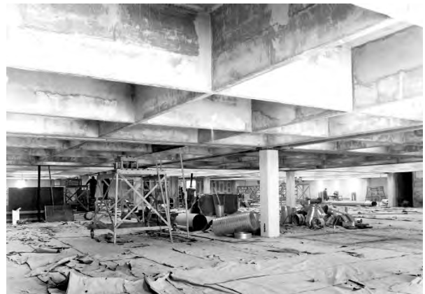
Kuva 49. Kirjaston sisätila ja vesikaton betonipalkit.
