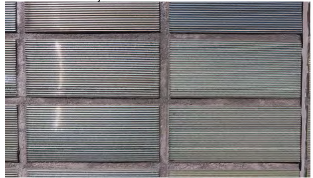
Kuva 131. Rakennuksen julkisivupinnan laatoitusta.
