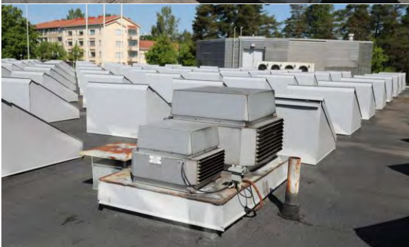
Kuva 128. Kuvia kirjaston katolta, ikkunoista ja asennuksista.
