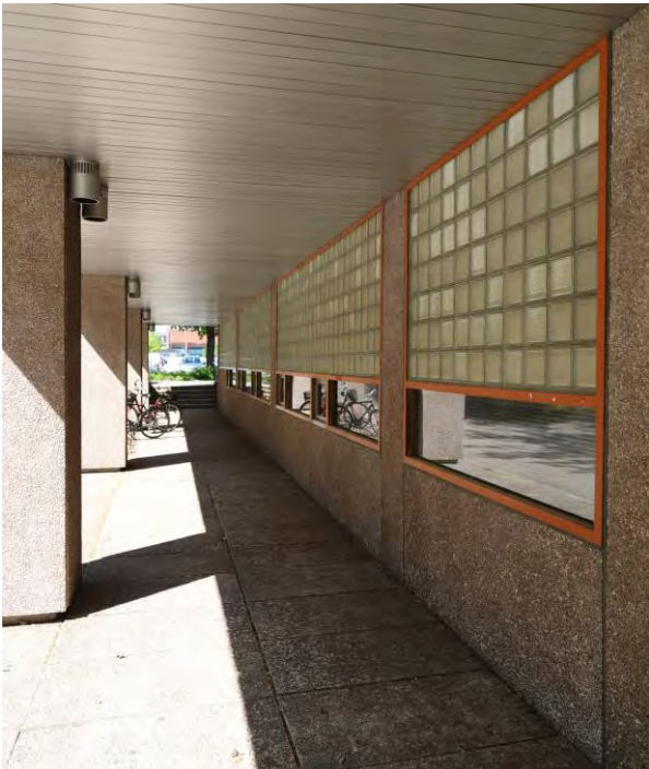
Kuva 122. Kellarikerroksen arkadikäytävä ja kellarikerroksen lasitiili-ikkunat. Alaosassa olevan ikkunan kautta pöydän äärellä istuva henkilö näkee ulos.
