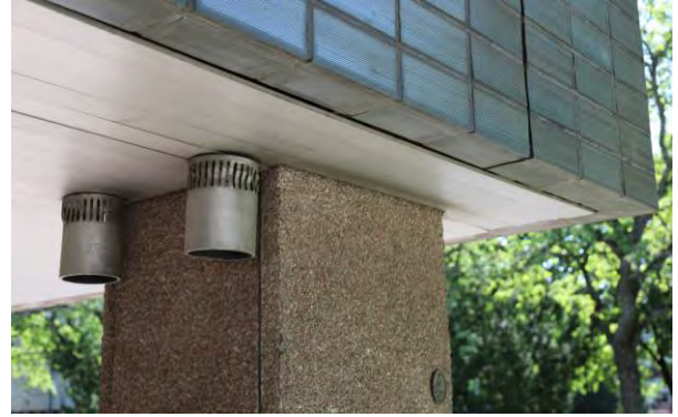
Kuva 129. Arkadikäytävän katoksen liitos.
